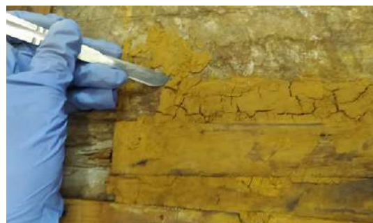
Fig.31. Retirada de resina epoxídica mecànicament.
