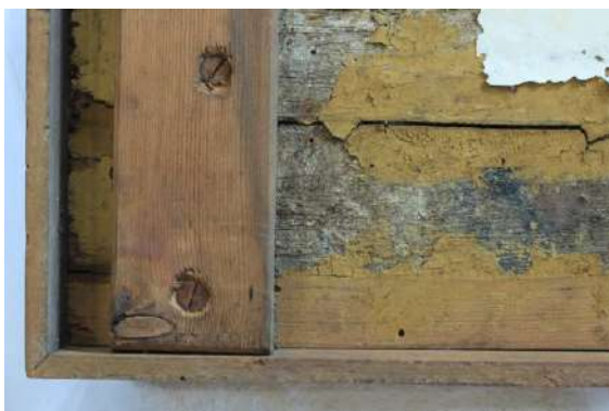
Fig.6. Detall d'un travesser unit a la fusta original amb cargols ara rovellats. També s'observa una esquerdada al suport.
